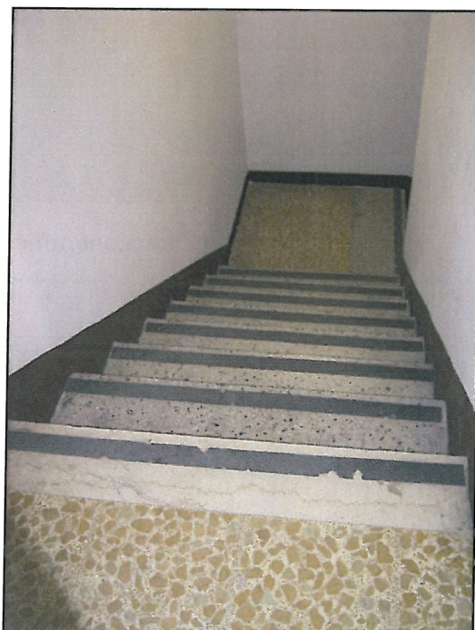
Scala d'accesso al piano interrato
