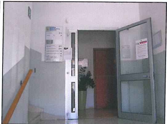
Porta d'ingresso al piano rialzato
