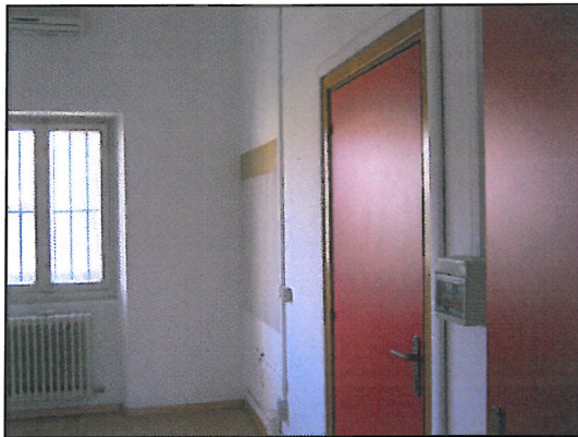
Particolare locale ufficio
