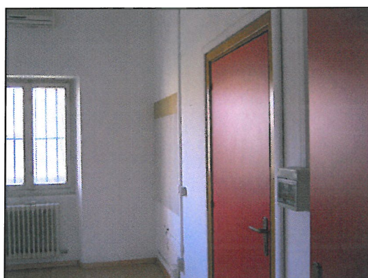
Particolare locale ufficio
