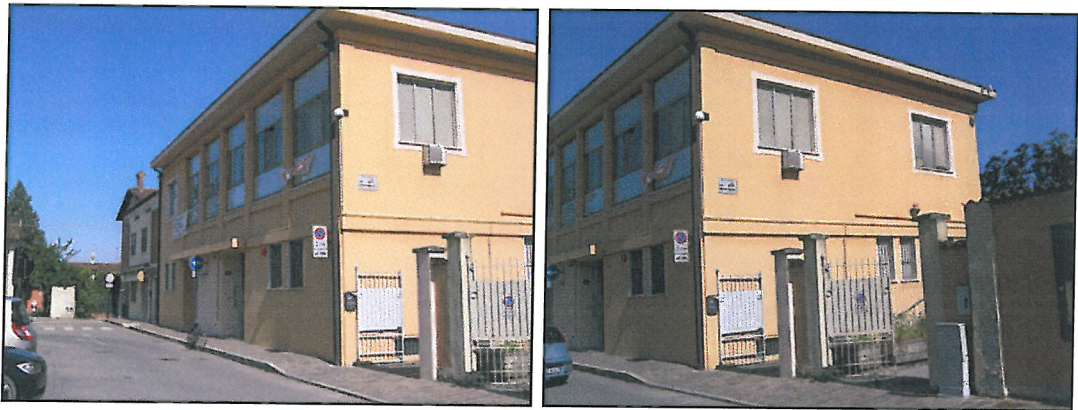
Vista lato sud ed est
