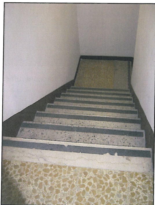
Scala d'accesso al piano interrato
