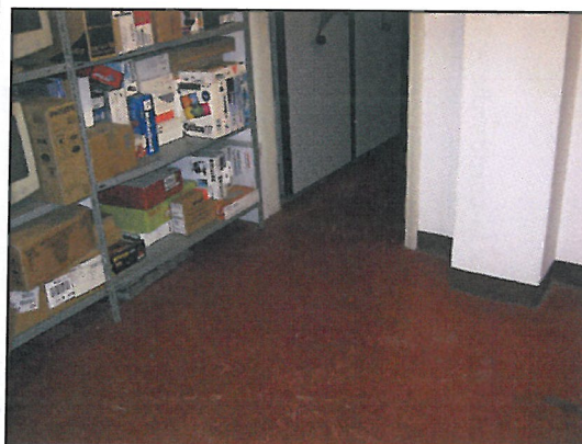
Particolare pavimento piano interrato
