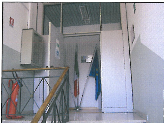
Ufficio al piano primo
