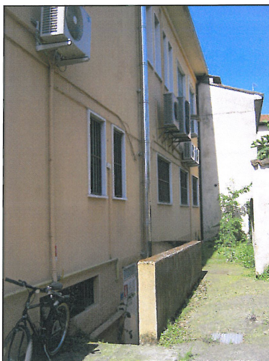
Particolare facciata nord
