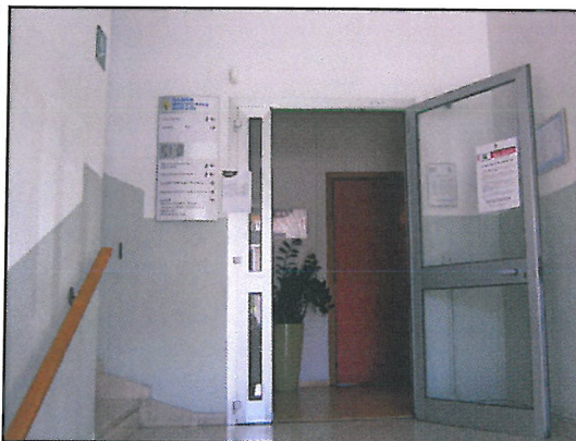
Porta d'ingresso al piano rialzato
