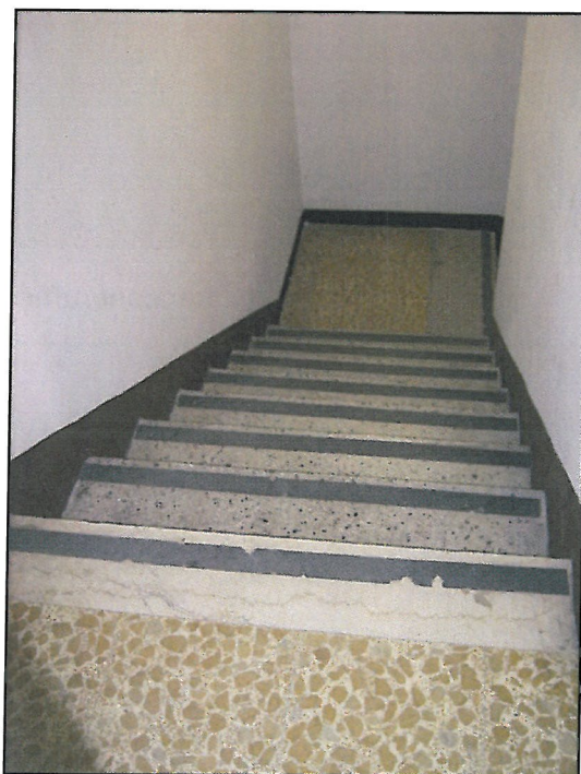
Scala d'accesso al piano interrato
