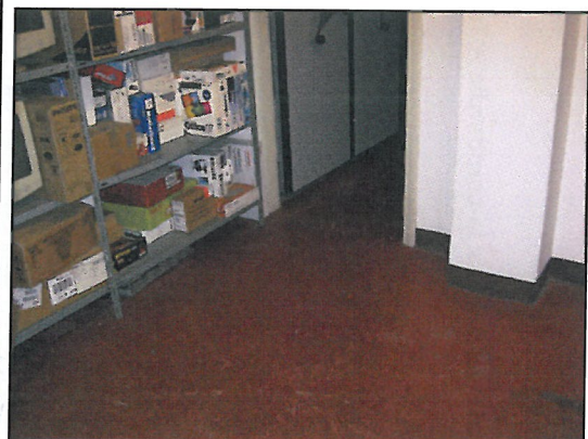
Particolare pavimento piano interrato
